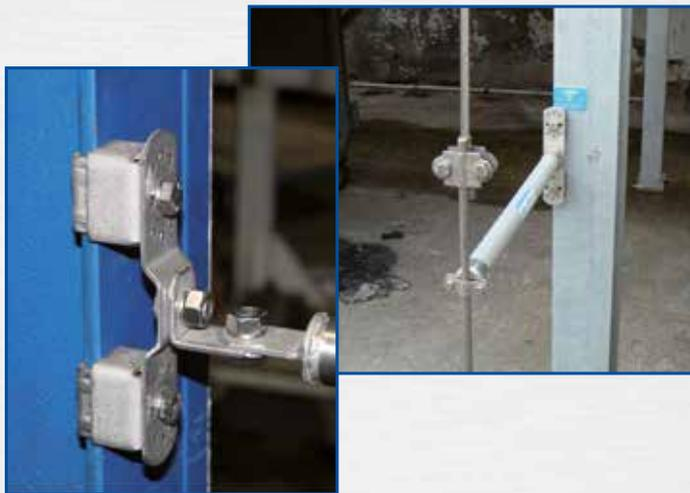
**Soporte de Instalación** para Isodistanciador transversal con Orejeta.
