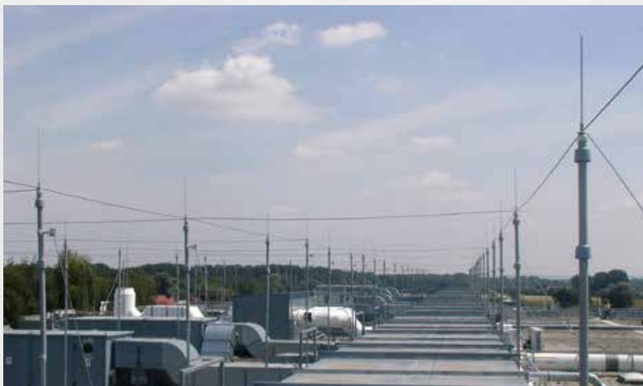
**Isodistanciador transversal**, con abrazadera de tubo, Altura ajustable en el tubo de soporte V2A ø 42 mm (mástil de intercepción) con cabezal de sujeción para cable de Aluminio ø 8-10 mm
