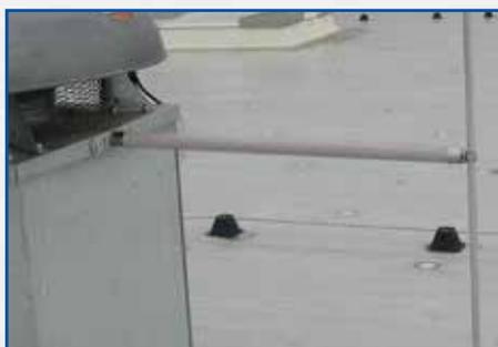
**Isodistanciador transversal** con soporte para sujetarse con cinta plana (Acero inoxidable V2A).
